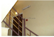
راه پله ساختمان (16 تصویر)
