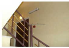
راه پله ساختمان (16 تصویر)
