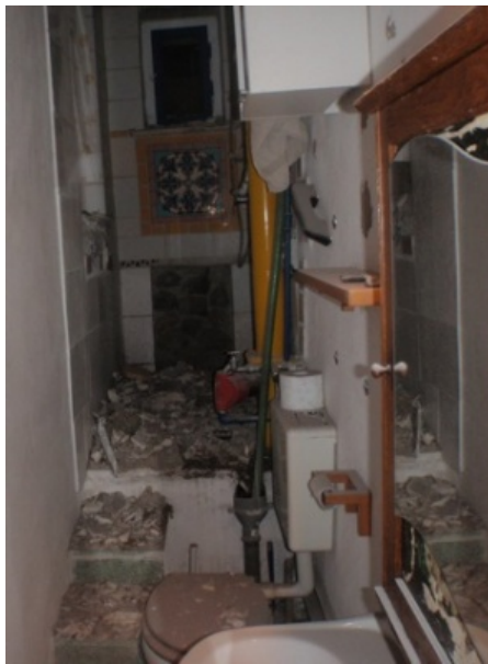
Altbau-Badezimmer 2014 – Beginn der Baumassnahmen
