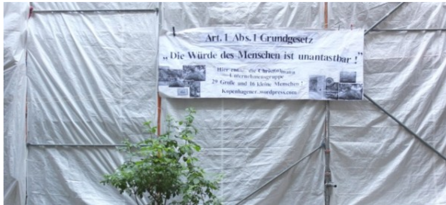
Mieter hinter Bauplane verpackt! – Brutale Sanierungspraxis in der Kopenhagener Straße 46 in Prenzlauer Berg
