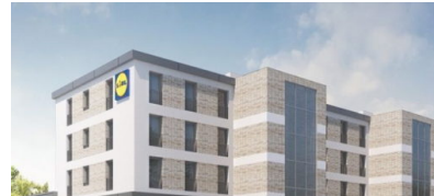
Lidl präsentiert erste Filiale mit Wohnungen in Modulbauweise
