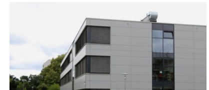
Neubau einer 4-zügigen Grundschule
