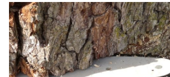
Notfällung einer Linde im Heegermühler Weg
