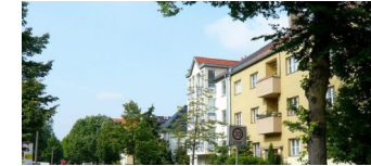
Fortsetzung der Bauarbeiten in der Schönstraße ab 13. Mai 2019
