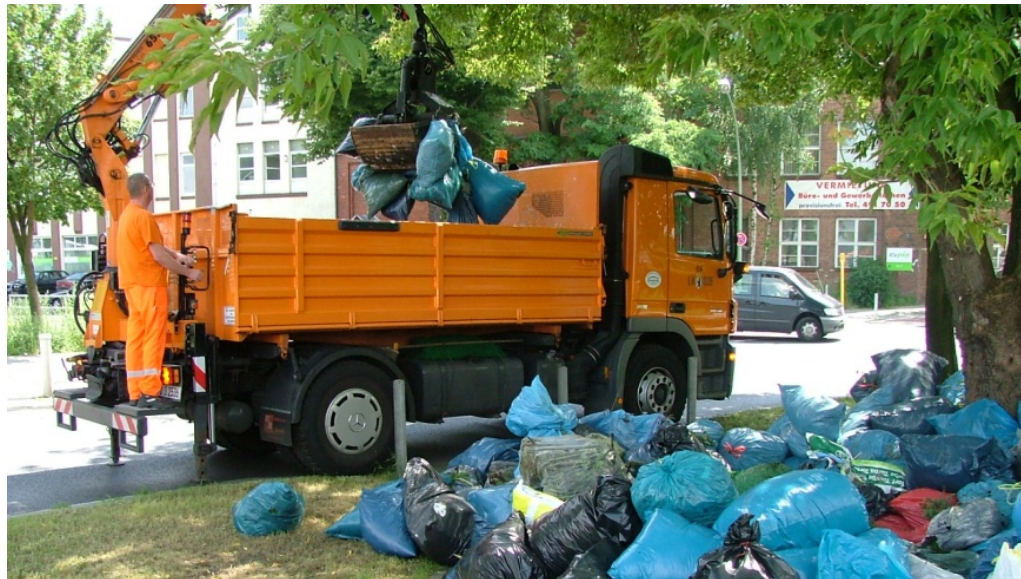
Beseitigung von illegal abgelagerten Abfall im öffentlichen Straßenland - Foto: Bezirksamt Pankow, T. Schietzelt
