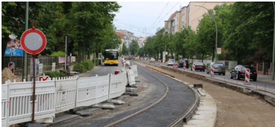
Neue Tramschienen in der Grabbeallee: Bauarbeiten im Sommer 2015
