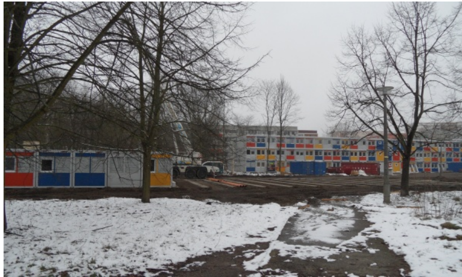
Flüchtlingsunterkunft an der Karower Chaussee im Bau
