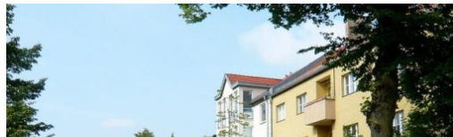
Fortsetzung der Bauarbeiten in der Schönstraße ab 13. Mai 2019
