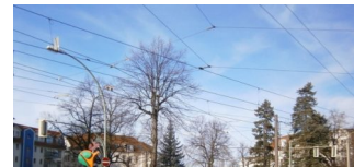
Pastor-Niemöller-Platz wird zur Baustelle
