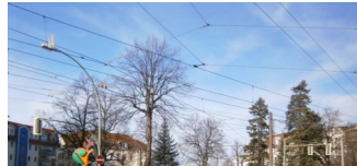
Pastor-Niemöller-Platz wird zur Baustelle
