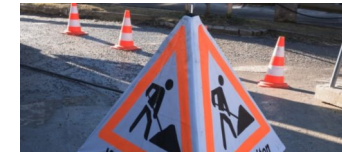
Bauarbeiten in der Bahnhofstraße bis Sommer 2020
