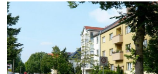
Fortsetzung der Bauarbeiten in der Schönstraße ab 13. Mai 2019
