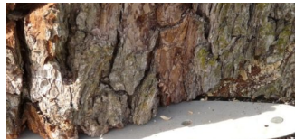
Baumarbeiten in der 14. Kalenderwoche
