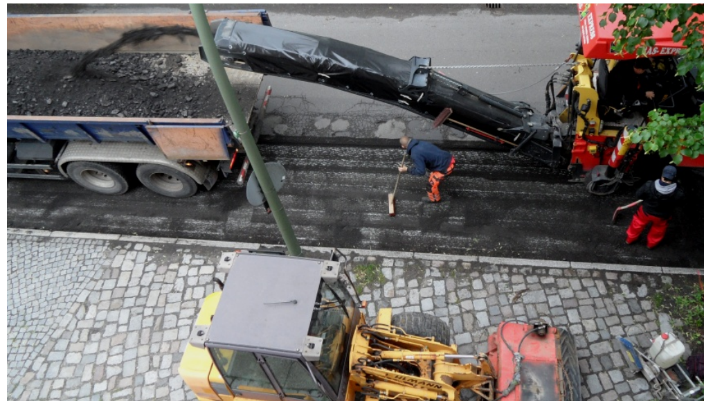
Straßenbauarbeiten starten in der Erich-Weinert-Straße in Prenzlauer Berg: hier Asphaltfräse im Einsatz - Foto: Symbolbild m/s
