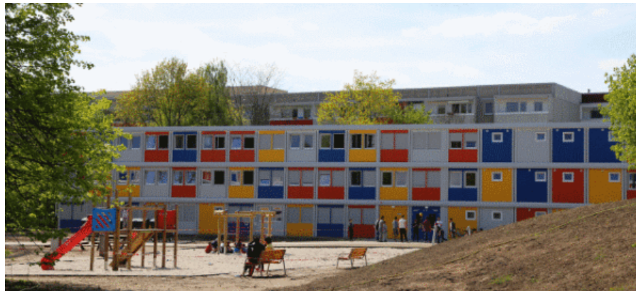
Container-Bau: Refugium Buch in der Groscurthstr. 29
