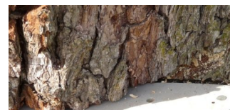
Baumarbeiten in der 14. Kalenderwoche
