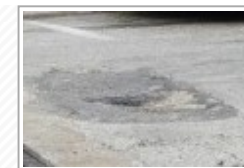
Canicatti, lavori manutenzione strade comunali interne al centro abitato
