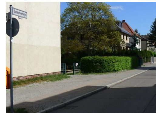
Fahrbahninstandsetzung in der Borggrevestraße
