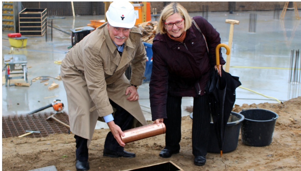
Bezirksbürgermeisterin Angelika Schöttler versenkt gemeinsam mit Firmeninhaber Thomas Dreusicke, Geschäftsführer der Dreusicke-Gruppe, die Zeitkapsel bei der Grundsteinlegung des neuen Betriebsgebäudes - Foto: © FREYLER
