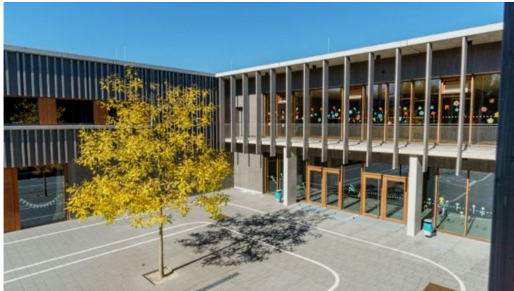
Grundschule am Ilse-von-Twardowski-Platz in München mit umlaufenden Fluchtbalkon - Foto: Norman Heise
