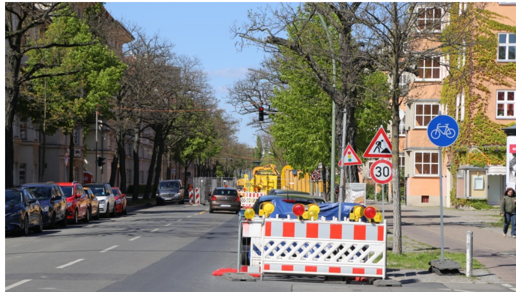
Baustelle Rubensstraße wird am 15.11.2017 aufgehoben - Foto: tsz
