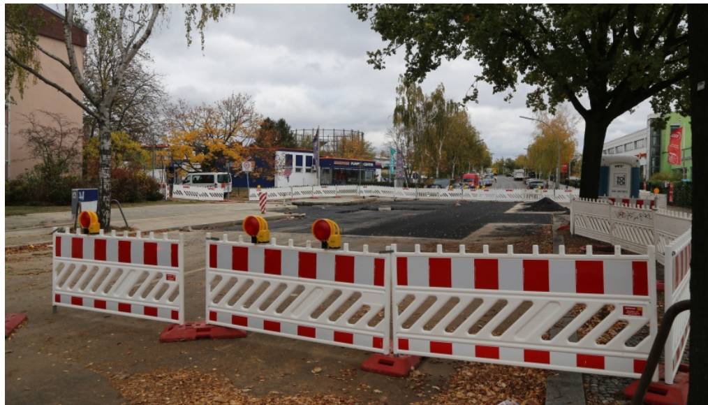
Baustelle Kamenzer Damm / Dittersbacher Weg am 27.10.2018 - Foto: szz
