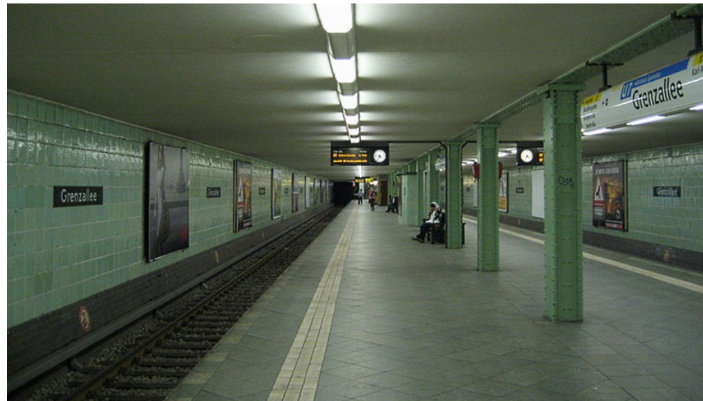
U7 mit Bauarbeiten zwischen Grenzallee und Britz- Süd - Foto; A.Savin CC BY-SY 3.0
